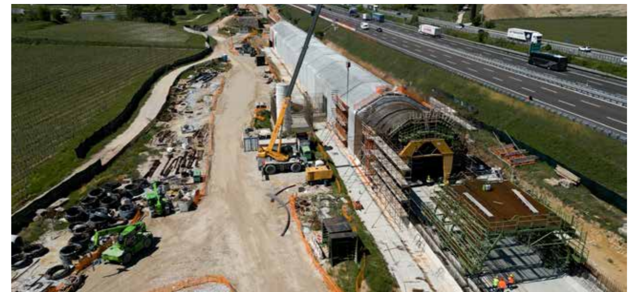
Cantiere di Ferroberica: galleria artificiale per la TAV Brescia-Verona a Peschiera del Garda (VR)
